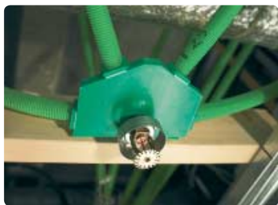
Montering av dold taksprinkler
